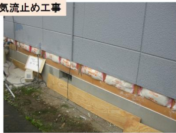
気流止め工事
